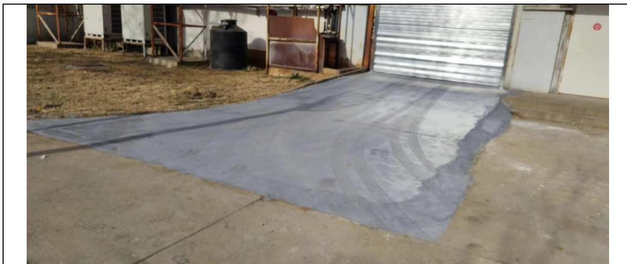
化镀车间地面防渗层修补
