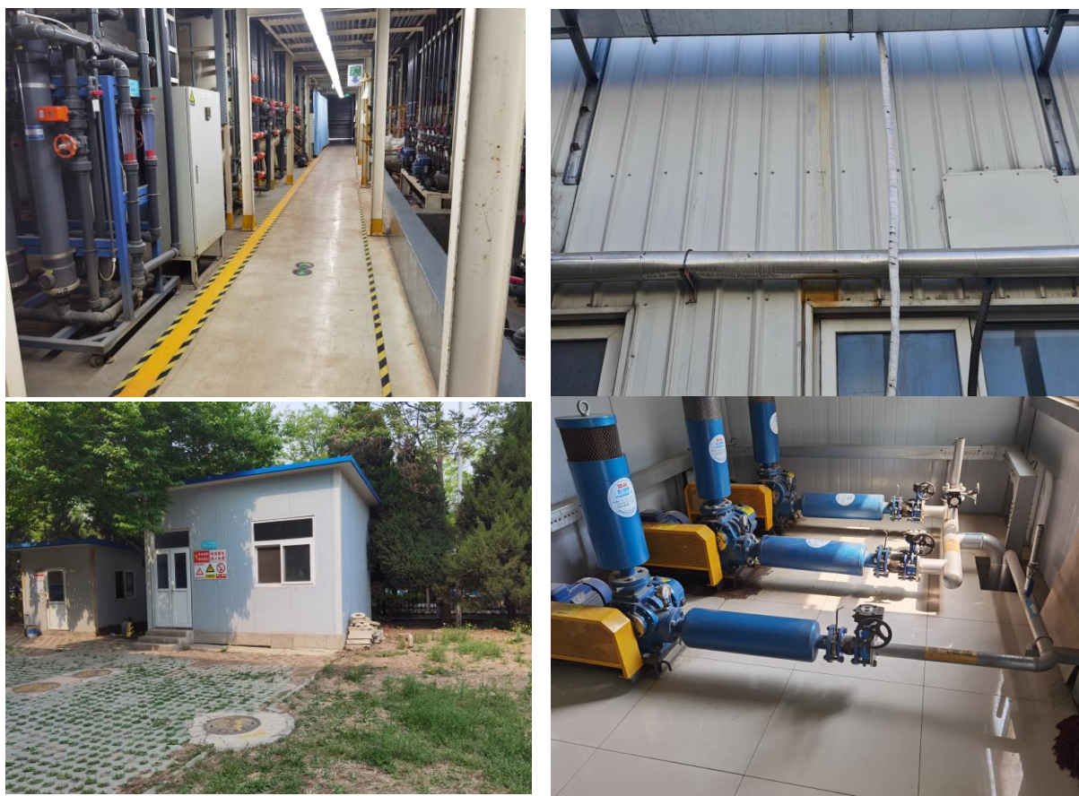
图 4-8 废水管道现场图
